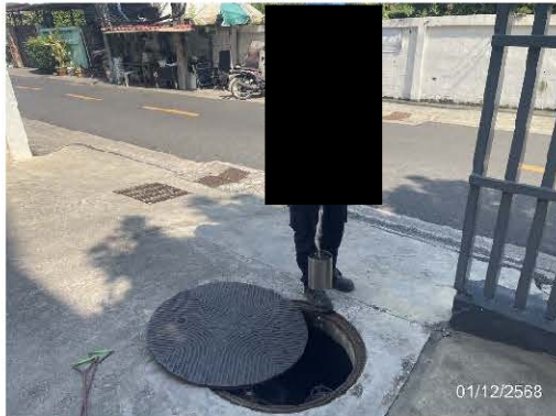
บ่อบำบัดน้ำเสียสุดท้ายก่อนปล่อยออกนอกโครงการ ภาพที่ 3.5.3-1 จุดเก็บน้ำทิ้งบ่อบำบัดน้ำเสียสุดท้าย
